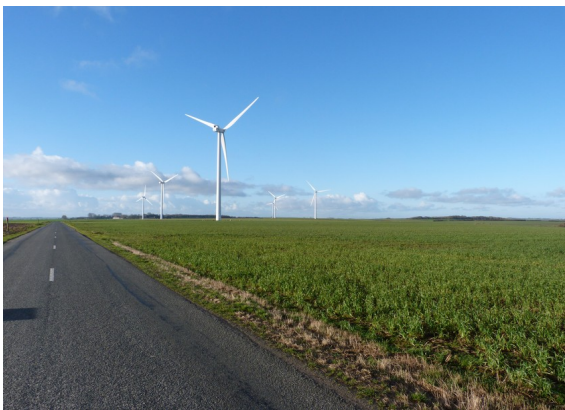
Vue du parc éolien prise de la RD 138E1 sens Lambus-St Josse au bois
